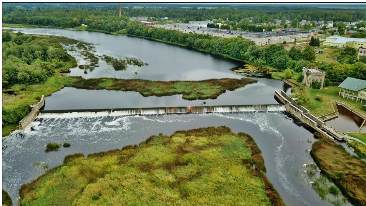
**Figure 4 :** Barrage de Sindi sur la Pärnu en Estonie. Barrière à la migration de l'esturgeon et d'autres espèces de poissons. Notez la passe à poissons à droite sur la photo (© Jarko Jaadla).
