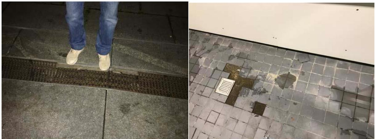
Photos 16 & 17 - Couvertures de drain et tuiles desserrées
