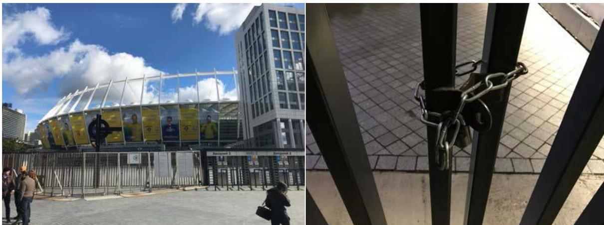
Photos 13 & 14 Clôtures temporaires en forme de V bloquant les portes de sortie à l'extérieur et portes de sortie cadennassées de l'intérieur.
