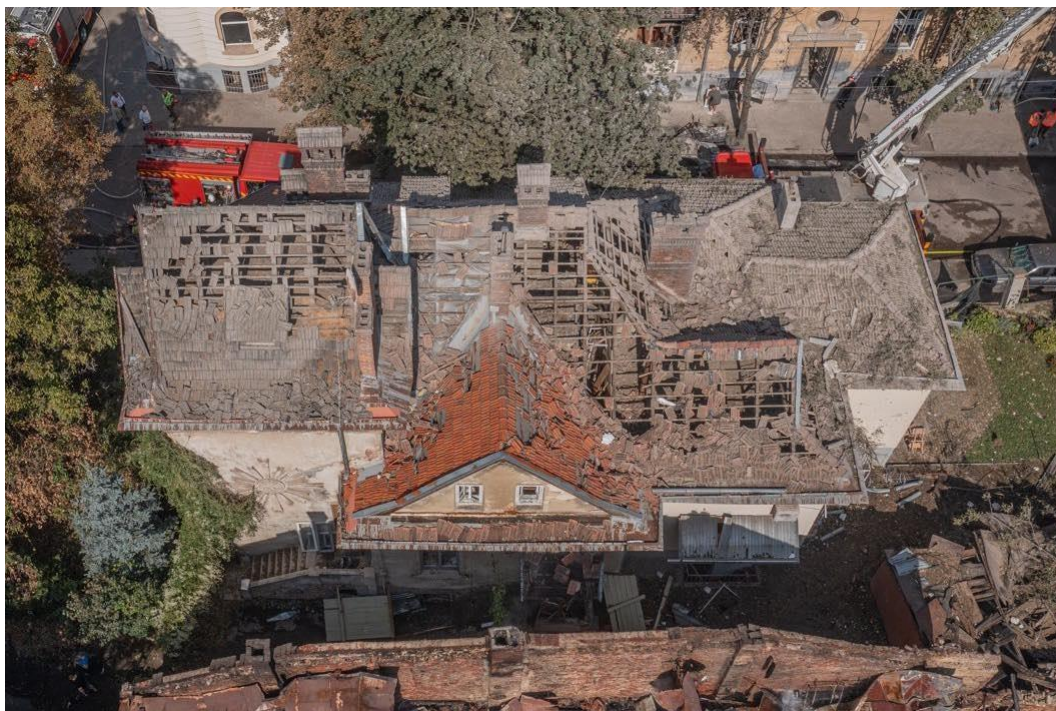
Figure 1. Dégâts subis par la « Villa Sonechko » à Lviv à la suite d'un tir de missile le 4 septembre 2023. Le bâtiment est situé dans le centre historique classé par l'UNESCO et sa zone tampon, où plusieurs sites patrimoniaux ont été endommagés lors de l'attaque.
