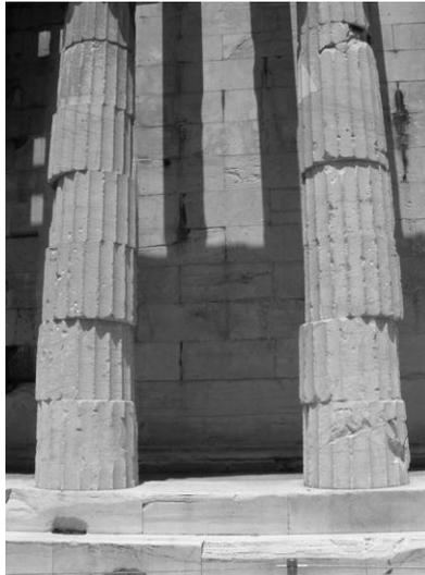
Figure 1: Effets d'oscillation et de déplacement de tambours de colonnes [3]
