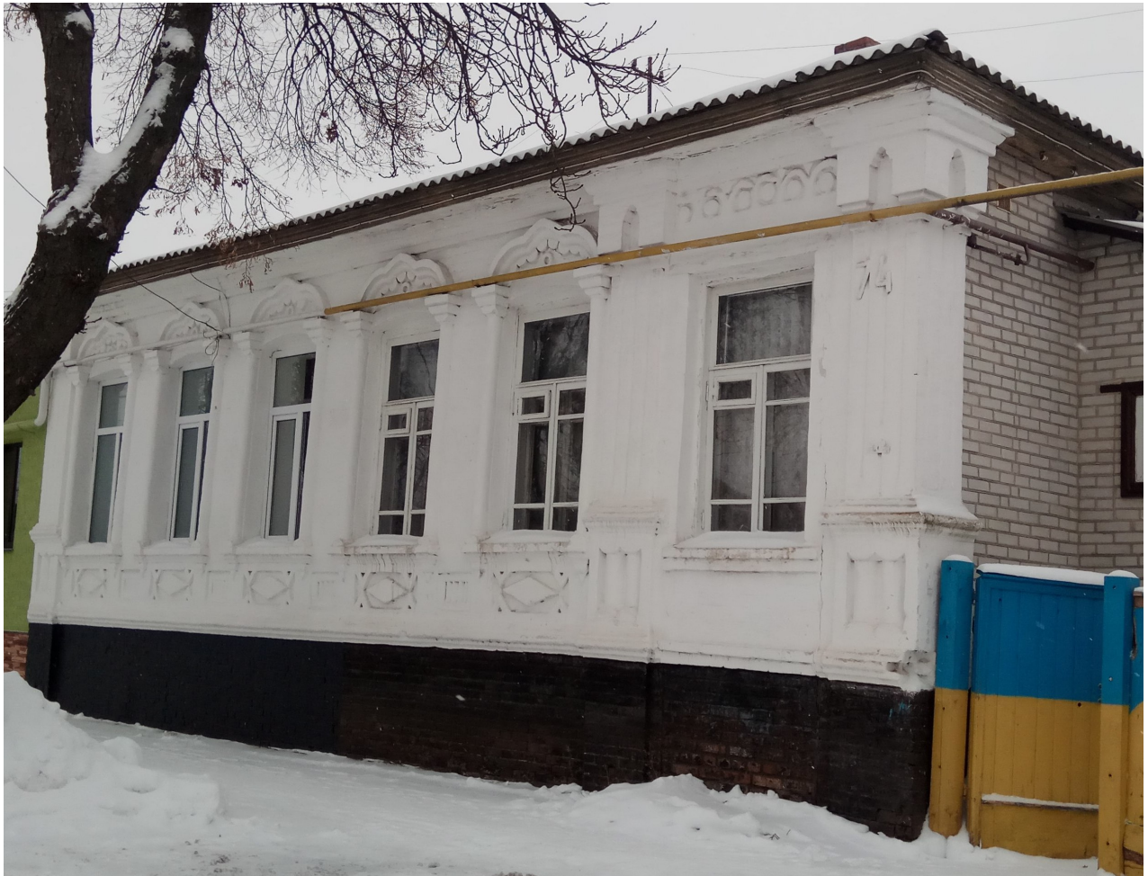
Приклади «відкритої» архітектури фасадів вул. Гімназична
