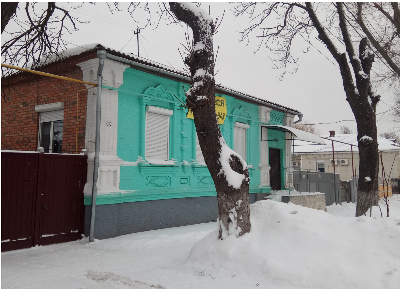
Приклади «відкритої» архітектури фасадів вул. Гімназична
