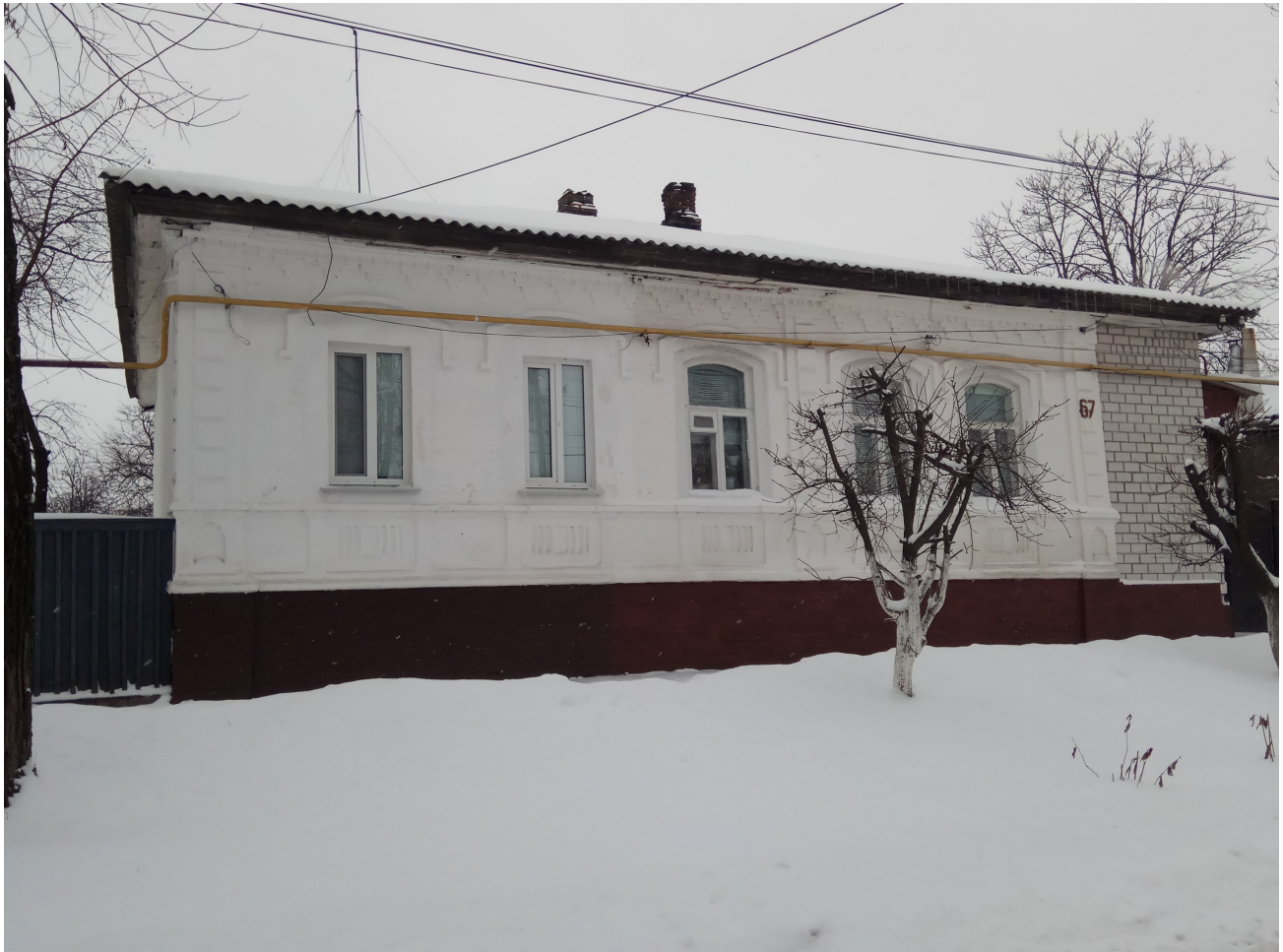
Приклади «відкритої» архітектури фасадів вул. Гімназична
