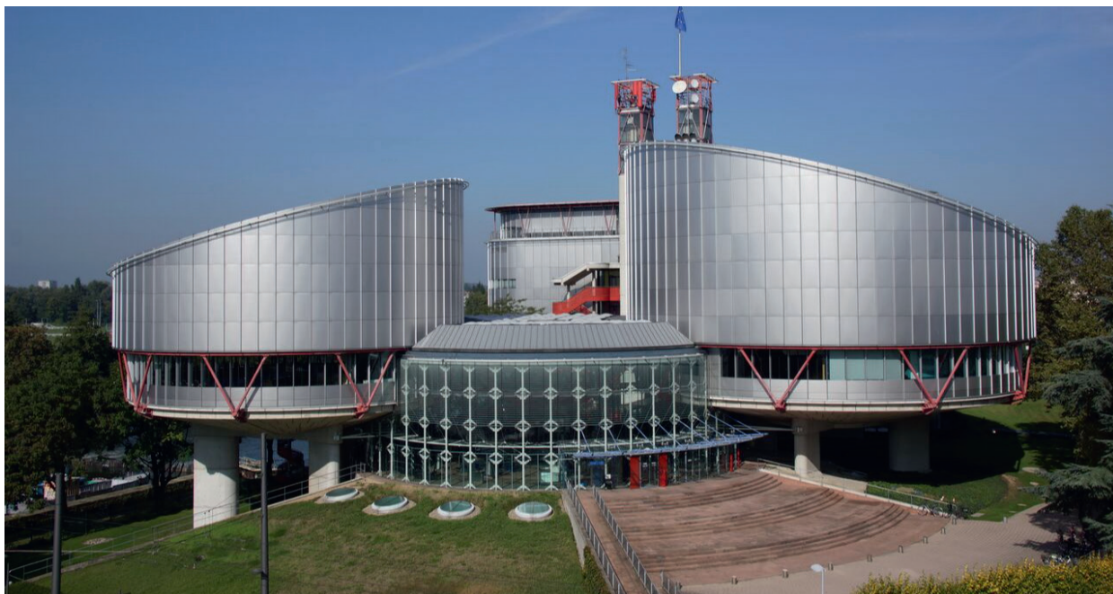
Foto: Clădirea Curții Europene a Drepturilor Omului, Strasbourg, Franța
