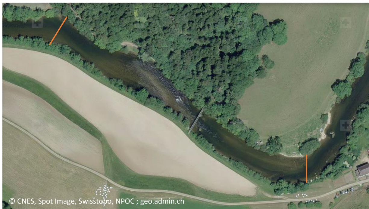
Figure 7 : carte et photo aérienne de localisation de la station La Charbonnière
