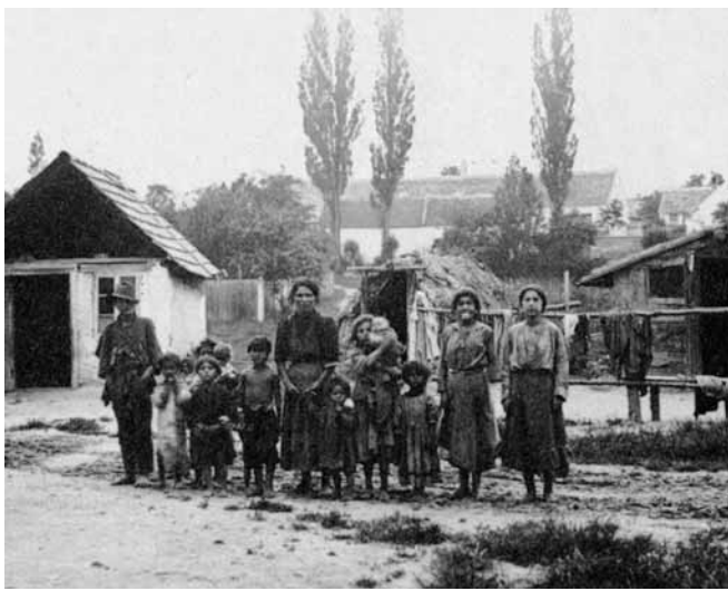
Ill. 4 – Insedimento a Mattersburg, Burgenland, tra le due guerre. L'immagine mostra i tre diversi modelli di abitazioni che esistevano allora: a sinistra, una casa intonacata e imbiancata di mattoni; nel mezzo un "Putri", un rifugio a metà scavato nella terra, a metà in legno, rame e argilla; a destra, una costruzione in argilla, e per metà in legno. (da Mayerhofer 1988, p. 184).
