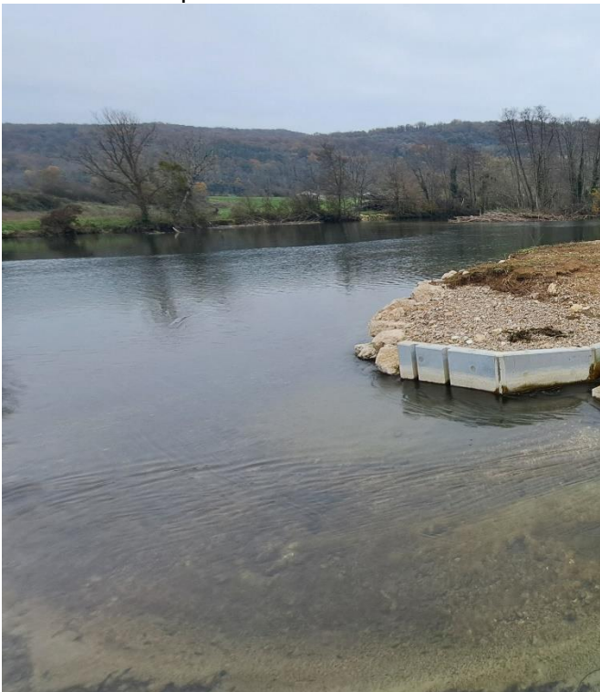
Photographie de la passe à poissons aménagée en 2024 au niveau du seuil de la centrale
