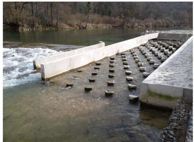
Photographies de la passe à poissons aménagée en 2020 au niveau du seuil AEP de Chenecey-Buillon
