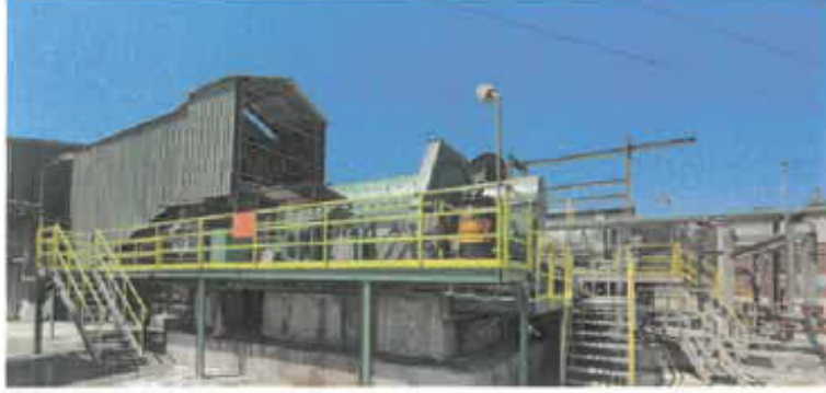
Fotoğraf 1. ETAN tesisi genel görünüm
