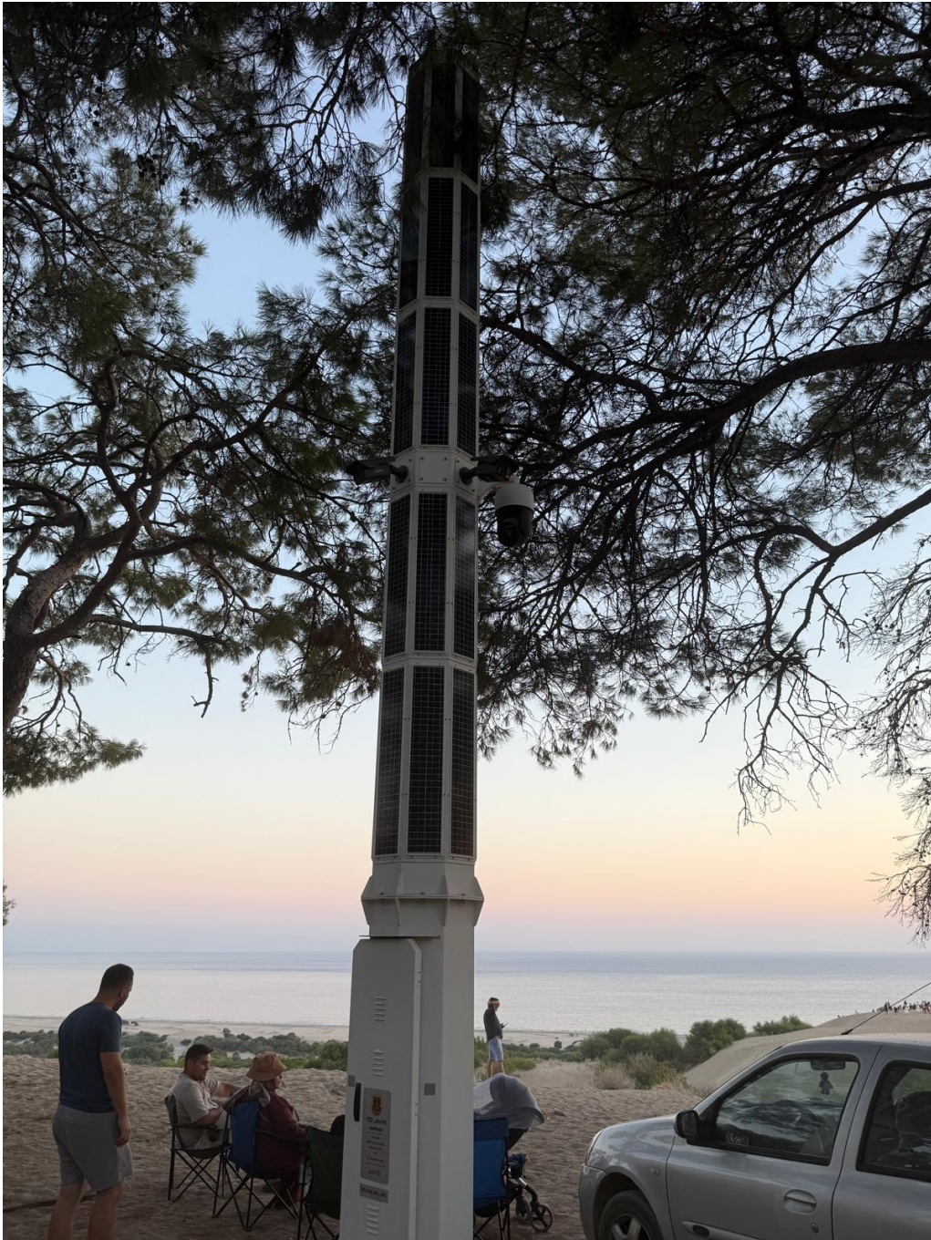
Installed cameras. (Fig. 22)
