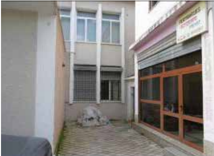
Dritare të mbrojtura të dhomës së regjistrave/ dokumentacionit
