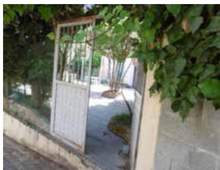
Portë që del në pronë private dhe në hyrjen për në rampën e përdorur nga automjetet e shoqërimit të të pandehurve të paraburgosur
