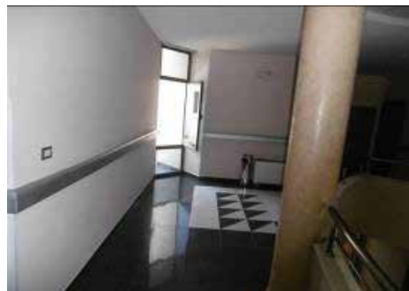
Dritare që hapet mbi një korridor
