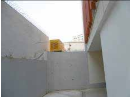
Rampa e aksesit në parking
