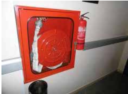
Kabina e zorrës së ujit dhe fiksës së zjarrit
