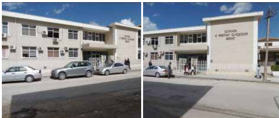
Pjesa e përparme e gjykatës, Rruga Antipatrea
