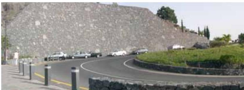
**III. 63.** *Le mur traditionnel au premier plan est associé à des éléments modernes, comme les bornes de sécurité. Le mur de soutènement est revêtu d'un parement traditionnel en schiste noir, tandis que l'accotement s'agrément de roches et de plantations incluant des essences locales. Ensemble, ces éléments créent une route au caractère bien marqué.*
