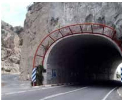
**III. 41 et 42.** Têtes de tunnels. A gauche : tunnel taillé à même le roc sur une route à une voie (île d'El Hierro, Espagne). A droite : un tunnel dans le val de Ricote (région de Murcie, Espagne) : auvent de protection décoratif et roche revêtue d'un enduit (photo : L. Cruz).
