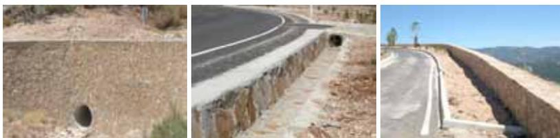
**III. 60, 61 et 62.** *Lorsqu'il est utilisé pour plusieurs éléments de voirie (murs de soutènement, fossés d'écoulement, parapets), le grès contribue à créer un sentiment d'identité et de cohérence.*
