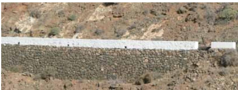
**III. 26.** *La plate-forme de la route repose sur un mur revêtu d'un parement en pierre locale. Associée à un pittoresque parapet de couleur claire, cette solution se révèle aussi esthétique que fonctionnelle.*
