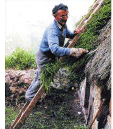
Αποκατάσταση κατεστραμμένης σκεπής, Asturias, Ισπανία
