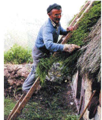
Restauration d'une toiture de chaume, Asturies, Espagne
