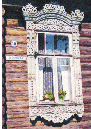
Fenêtre d'une maison traditionnelle en bois, Russie
