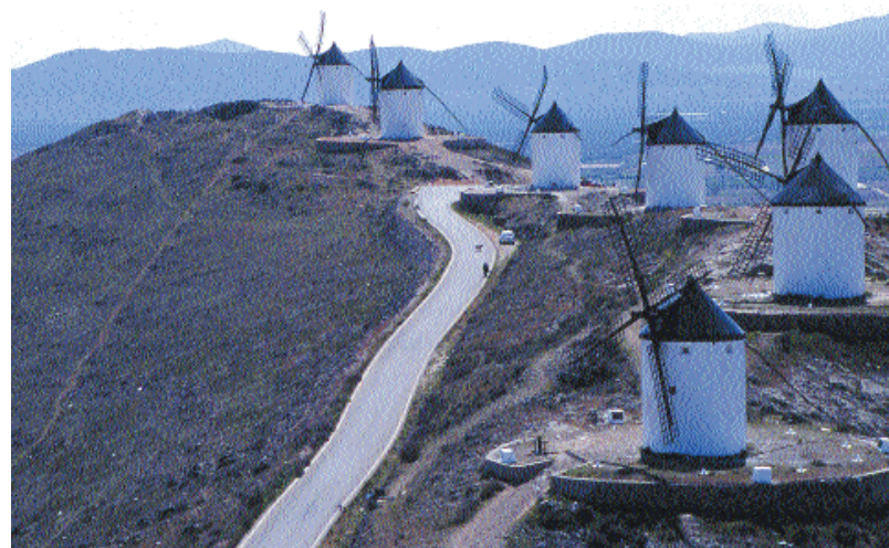
Moulins à vent du Consuegra, La Mancha, Espagne
