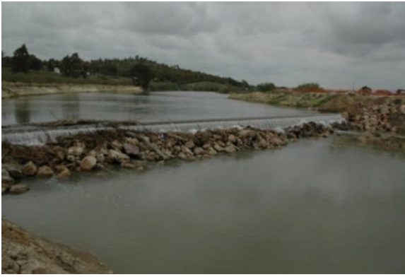
Barrage du Portal.
