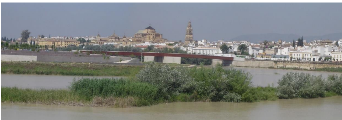
Fig. 1. Puente de Miraflores y frente monumental (Córdoba). Fuente: Cuello, A.
