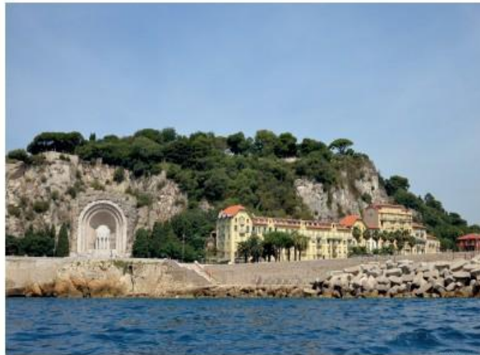
Sur la pointe où le vent glisse entre mer et roche, la plage a été recouverte d'engrèvements pour briser la houle à l'approche du port.
