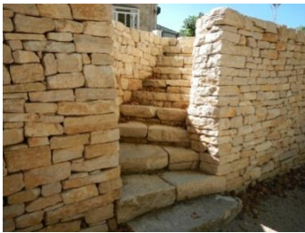
Fig. 58. Gargas, Luberon (Vaucluse), France. Construction: Maison des Métiers du Patrimoine. Technical supervisor: Matthieu Collot, waller.
