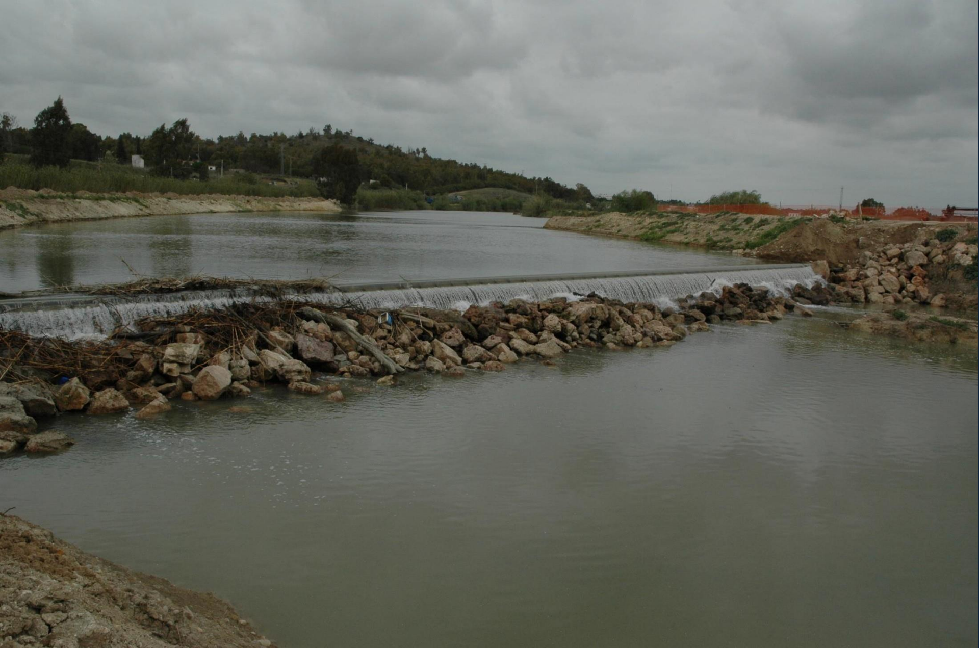
Barrage du Portal
