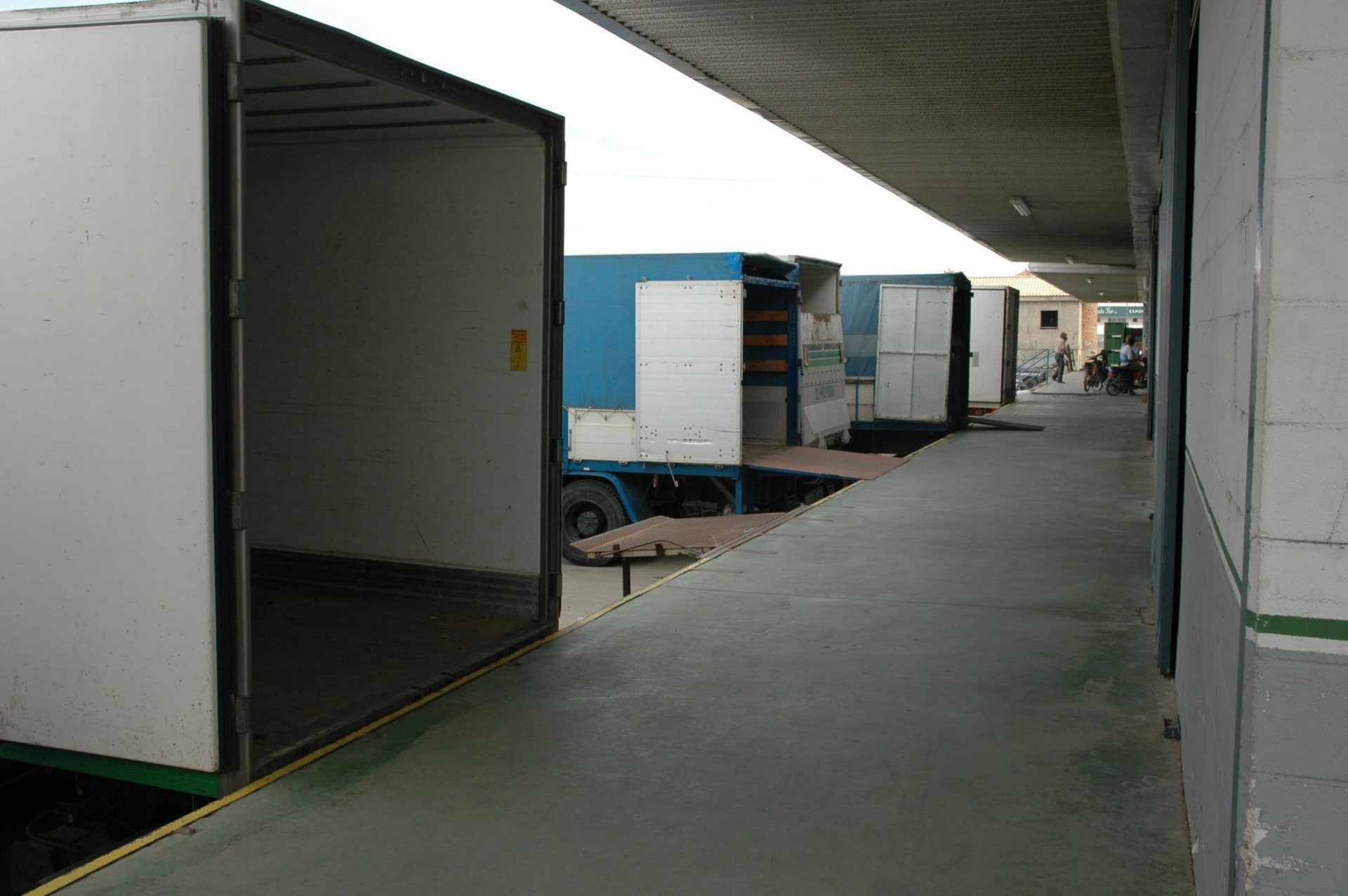
Camions frigorifiques prêts au chargement et au départ pour le nord
