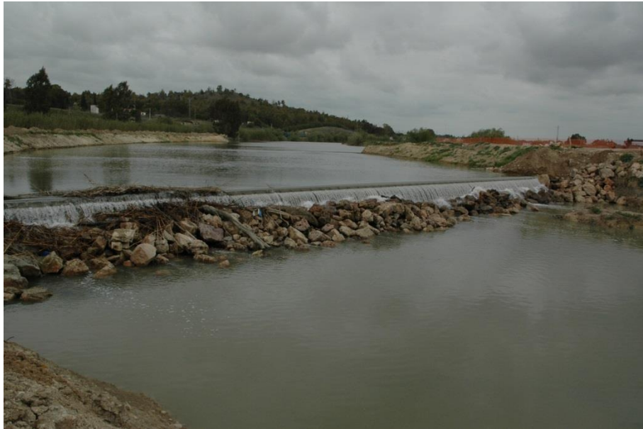
Barrage du Portal
