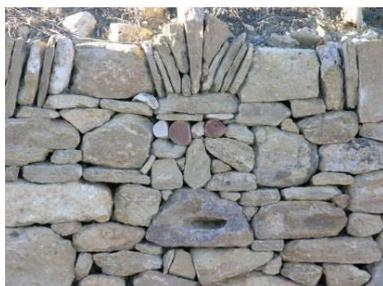
Fig. 11. Restauration d'un soutènement à Oppède Le Vieux, Luberon, Vaucluse. Chantier d'insertion « Maison des métiers du patrimoine ».
