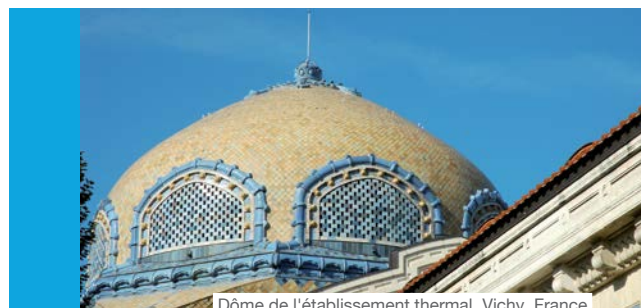
Dôme de l'établissement thermal. Vichy, France
