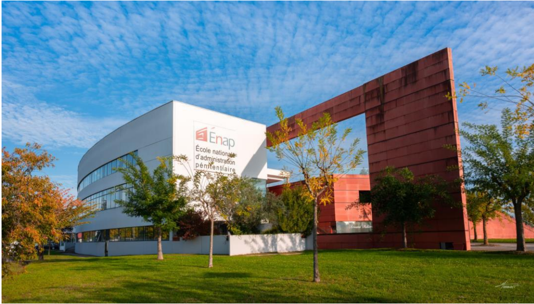
Zone administrative Ecole Nationale d'Administration Pénitentiaire d'Agen
