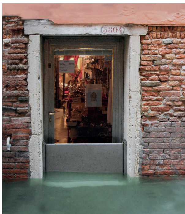
5. - Mobile flood barriers to stop the ingress of water. Barrières mobiles pour arrêter l'intrusion des eaux.
