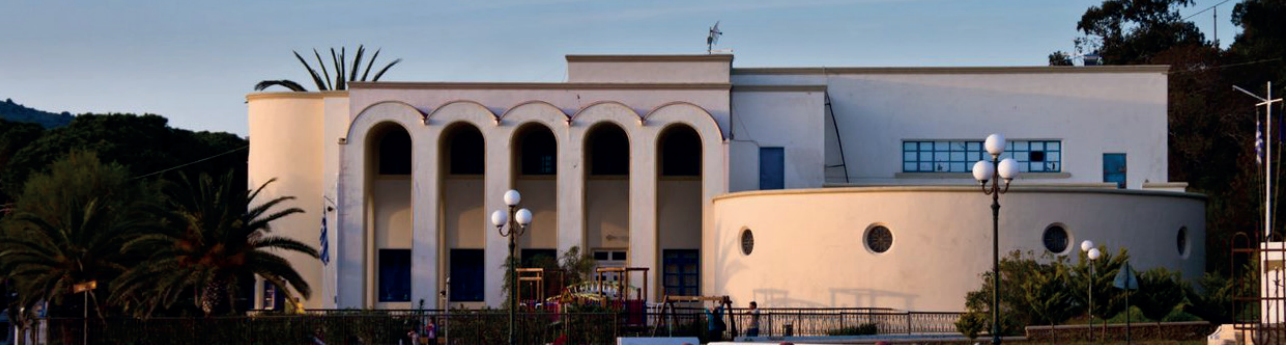
École primaire construite dans le style fasciste italien du Razionalismo, Lakki, île de Leros, îles du Dodécanèse, Grèce ©ATRIUM
