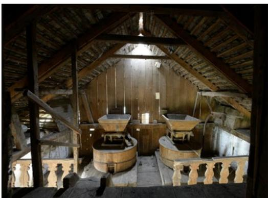
Des travaux ont été réalisés en urgence par le Musée national de Kikinda sur la toiture, le réseau d'évacuation des eaux usées et le mécanisme en bois. Des études réalisées par l'Institut national pour la protection des monuments culturels ont permis de stabiliser la structure et d'utiliser des matériaux d'origine, de façon à conserver l'authenticité du monument.
