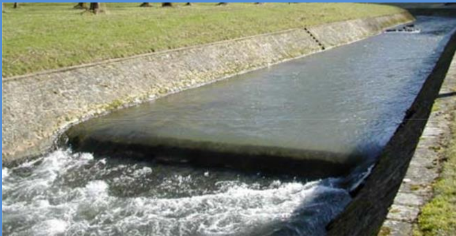
Situation avant travaux
