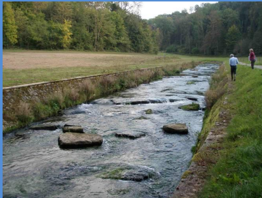
Situation après travaux
