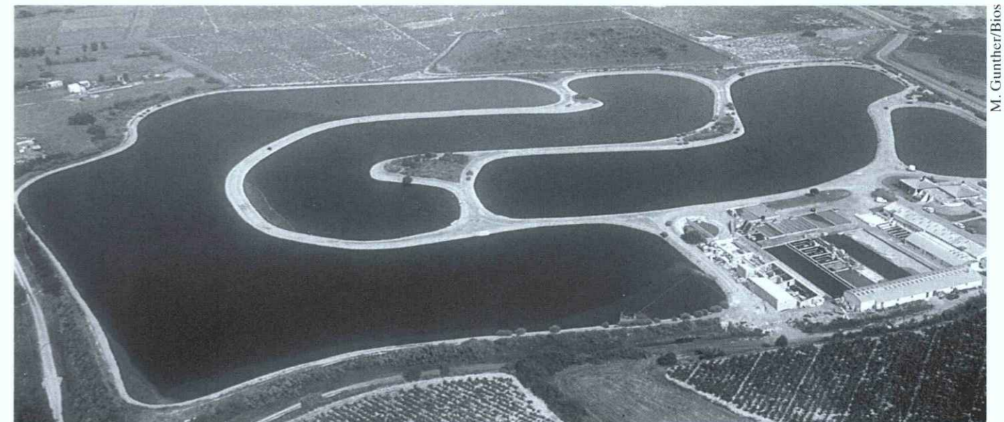
Le traitement des effluents est à prendre en compte, dans tous les cas. Une station d'épuration par lagunage comme ci-dessous peut même être accueillante pour la faune et la flore sauvages moyennant des aménagements particuliers.
