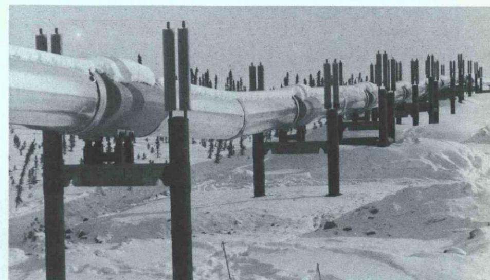
Notre soif d'énergie a parfois des conséquences négatives sur le paysage et l'environnement: ici le pipe-line d'Alaska qui est surélevé pour permettre le passage du grand gibier et conçu pour résister aux changements de température et aux secousses sismiques (Photo Bureau of Land Management)
