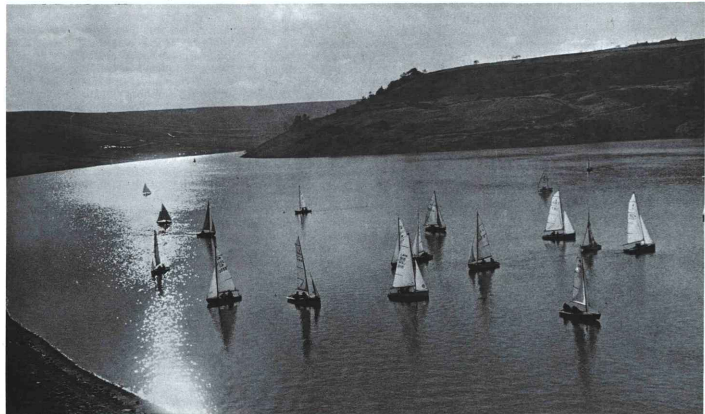
Pratique de la voile sur un nouveau lac de barrage - Scamonden Dam, près de Huddersfield, Royaume-Uni.
