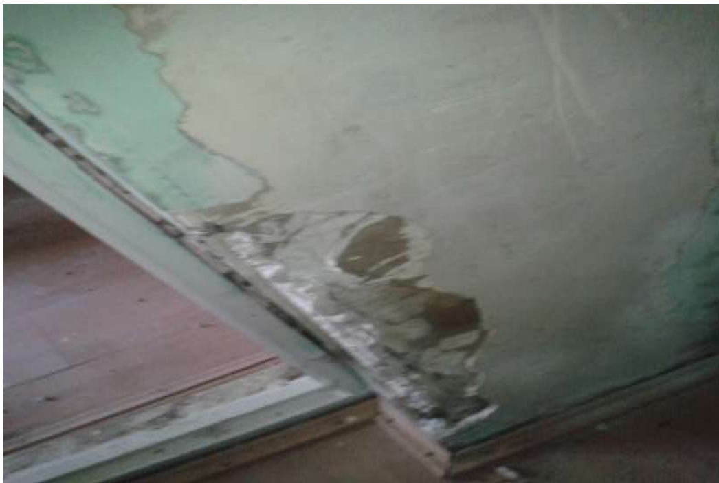
Fotografie 4. Imagine interior casă renovată
