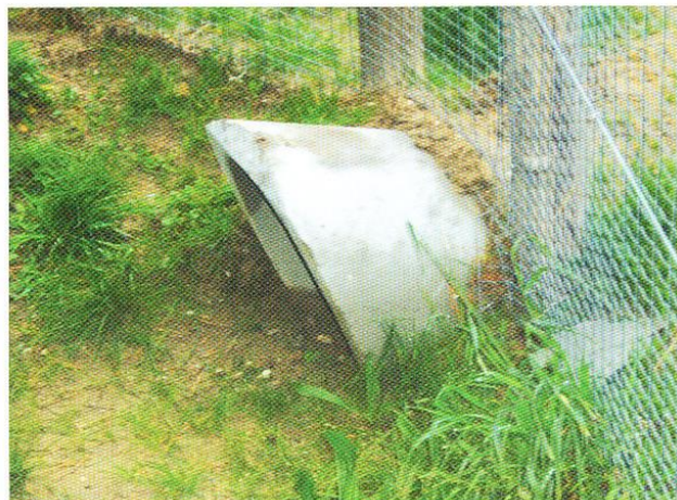
Dassentunnel: door het schuine uiteinde zal het minder snel inregenen
