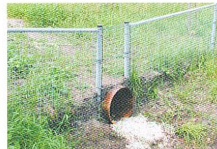
Dassentunnel met goede aansluiting op raster
