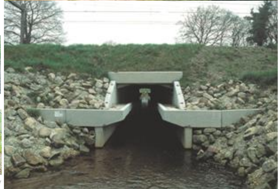
Dassentunnel met goede aansluiting op raster
