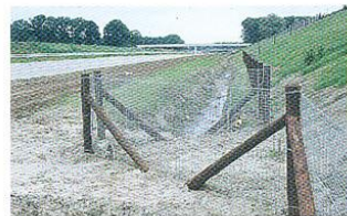
Raster sluit aan op ingang dassentunnel
