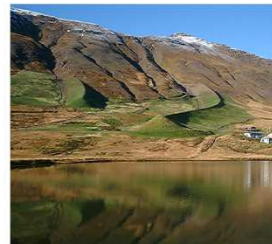
Estructures de protecció contra les allaus. Sigüfjordur, Islàndia.
