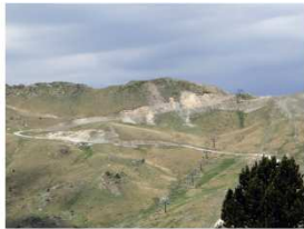
Els desnivells i els terraplens també afecten el prat alpí i les molles per sobre i per sota de l'actuació. Grau Roig, Grandvalira. Juny 2012.
