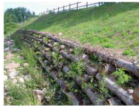
Mur de contenció fet amb entramat vià de troncs que poden provenir de la mateixa intervenció. Autors: Naturalea, www.naturalea.eu
