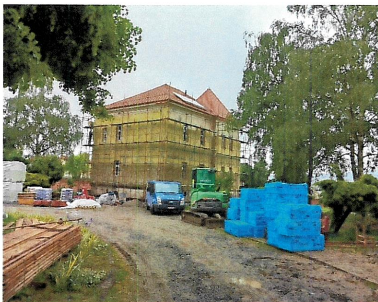
Zgrada stacionara i ambulante.
