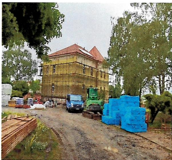
Zgrada stacionara i ambulante.
