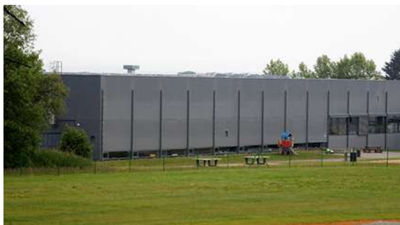
Fig. 16. Panneaux photovoltaïques mutualisés discrètement installés sur le toit d'un hall multisport à Beckerich, Luxembourg.
