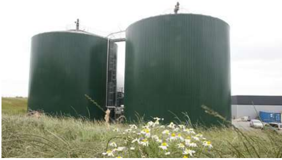
Fig. 52. Silos pour la production de méthane. (Photo C. Saidou/ministère de l'Agriculture, France)
