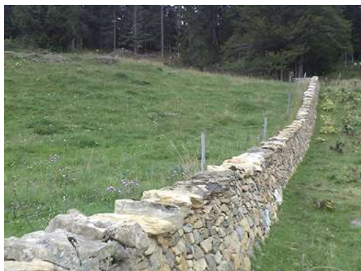
Fig. 22, Mur de clôture. (Photo R. Ambroise)
