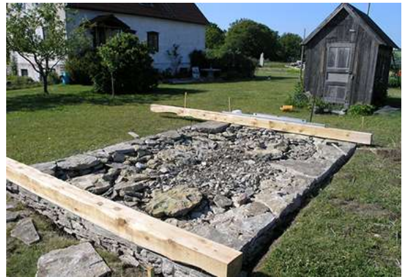
Fig. 67. Construction d'un chalet, île de Gotland, Suède.
