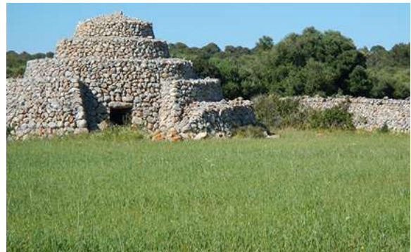
Fig. 75. Construction de pierre sèche pour s'abriter du vent (barraca), Minorque, Espagne.
