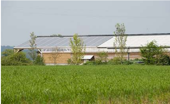
Fig. 53. Panneaux solaires sur le toit d'un hangar. (Photo P. Xicluna/ministère de l'Agriculture, France)
