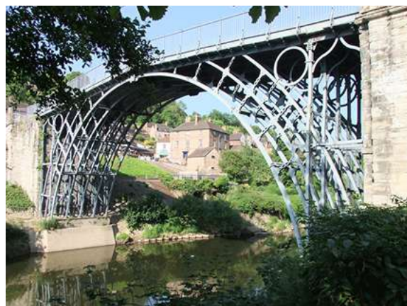
Fig. 24. Iron Bridge, Coalbrookdale, Angleterre, Royaume-Uni.
