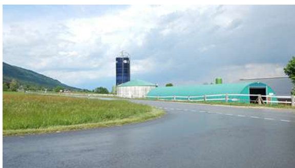
Fig. 24. Usine de biométhanisation, Jura, Suisse.
