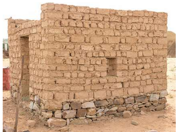
Fig. 69. Fondation et soubassement d'une maison neuve en briques de terre crue, Chinguetti, Mauritanie.
