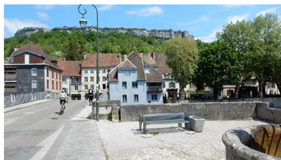
Fig. 28. Aménagement au bord du pont sur la Loue, Orans, France.
