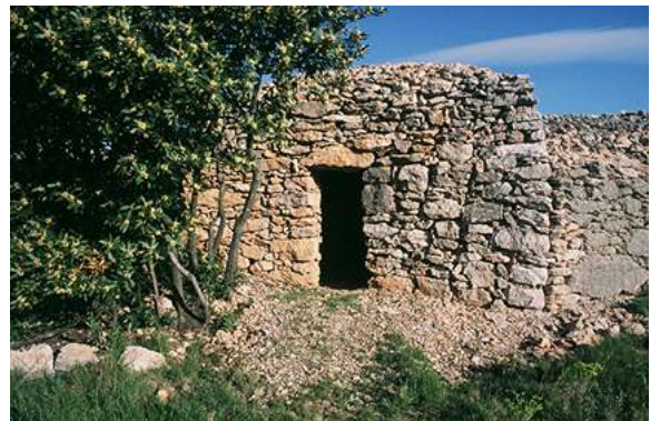
Fig. 77. Construction dans la clôture du vignoble, Saint-Chinian, Hérault, France.
