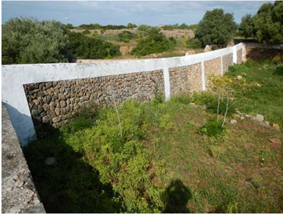
Fig. 8. Fond d'un jardin communal, servant de barrage en travers du talweg d'un vallon conduisant à la mer, Ciutadella, Minorque, Espagne.
