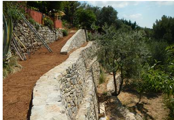
Fig. 60. Toulon, Var. Construction d'un soutènement par Albert Porri, murailleur, France.
