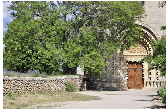
Fig. 54. Prieuré de Ganagobie, Alpes-de-Haute-Provence, France.
