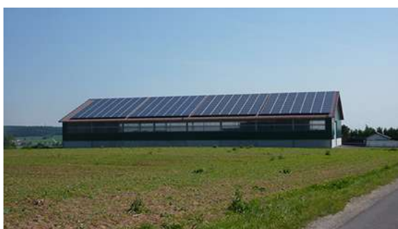
Fig. 15. Unité photovoltaïque sur un bâtiment agricole, Allemagne.
