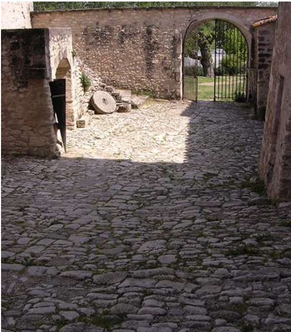
Fig. 64. Prieuré de Salagon, Alpes-de-Haute-Provence, France.
