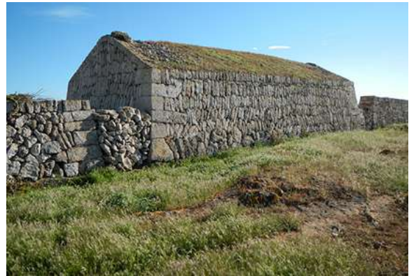
Fig. 76. Construction pour abriter les animaux (pont de bestiar), Minorque, Espagne.
