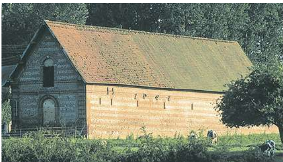
Fig. 14. Grange en pierres et briques en Normandie, France. (Photo R. Sauvaire)
