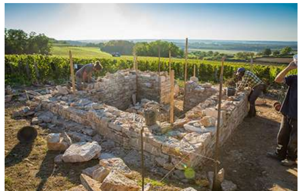
Fig. 68. Construction d'une remise dans le vignoble. Construction Laviers, murailleurs de Bourgogne, France. (Photo : J. Mari).
