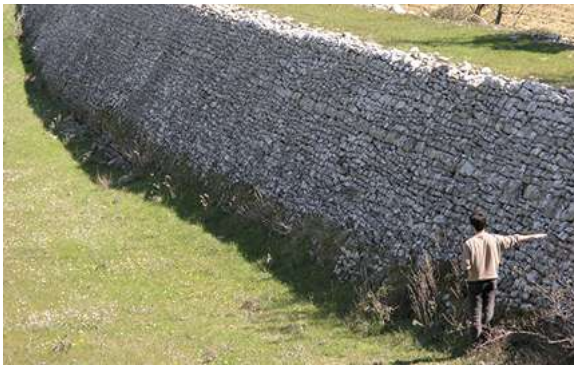
Fig. 100. La restanque (barrage en travers du talweg), Suisse. Le murailler montre le résultat du travail réalisé.
