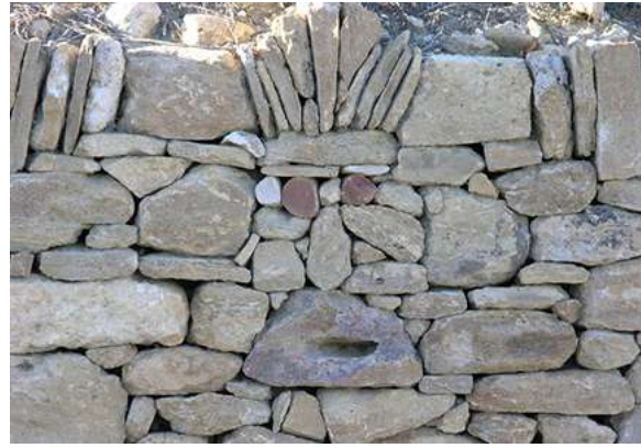
Fig. 11. Restauration d'un soutènement à Oppède-le-Vieux, Luberon, Vaucluse. Chantier d'insertion « Maison des métiers du patrimoine ».
