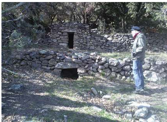
Fig. 84. Protection d'une source. (Photo R. Ambroise)
