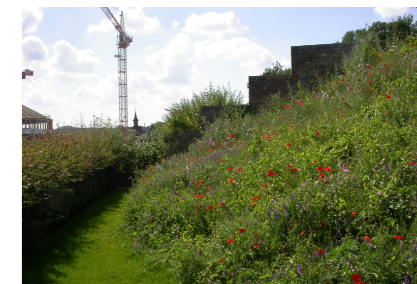
9 - Les vestiges des murs écroulés sont reprofités en talus végétalisés.
