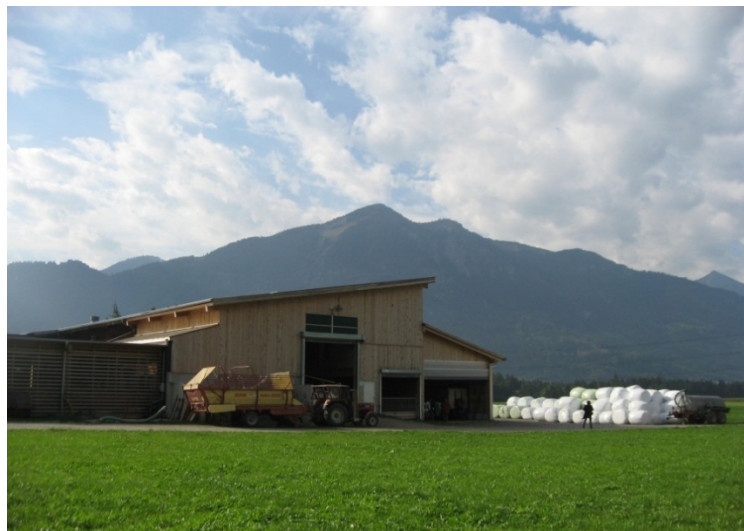
Nouveau bâtiment d'élevage en Autriche
