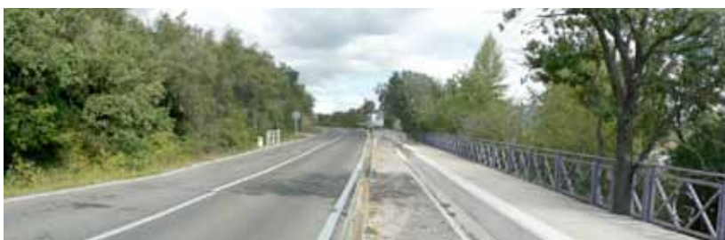
III. III-8. La construction d'une plate-forme latérale a permis d'aménager un chemin le long de la route. Un muret peint en blanc et une glissière de sécurité séparent les promeneurs de la circulation et une balustrade empêche d'accéder au rivage.
