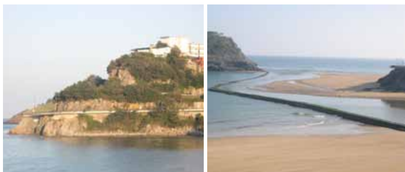
III. IV-4 et IV-5. A gauche : la route de Karraspio, taillée dans l'à-pic. Au-dessus, on distingue la route principale, qui mène à Ondarroa. À noter, la plate-forme en surplomb, sur la gauche. La mer est à marée haute. A droite : à marée basse, on distingue la digue de retenue du moulin à marée, qui parcourt toute la distance entre l'île San Nicolás et l'embouchure de la rivière. Tout à fait à droite, la plate-forme en surplomb soutenant la route de Karraspio.
