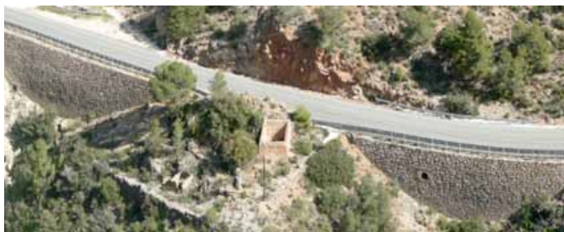
III. 78. Le recours à la pierre pour les murs de soutènement donne de beaux résultats.
