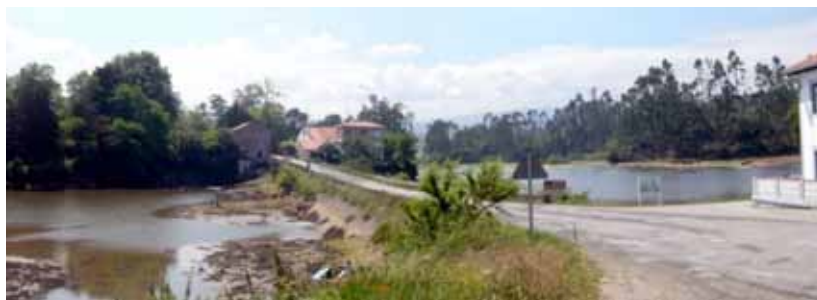
III. 70. Les routes peuvent provoquer divers effets de coupure. Ici, dans l'estuaire de la Rabia (Cantabrie, Espagne), les remblais affectent le cycle des marées, et donc la biodiversité des zones humides intérieures.
