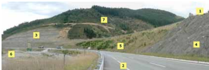
III. 76. Aménagement de deux voies supplémentaires. Les mouvements de terre, notamment s'agissant des voies rapides, jouent un grand rôle dans la présence de la route dans le paysage. Les infrastructures routières comprennent différents éléments, notamment ici : voies séparées (1 et 2), talus (4 et 5) et front de taille (3), voie de service (7) et zone destinée aux bâtiments de chantier (6).
