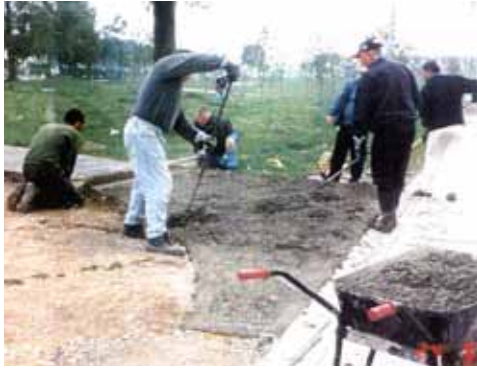
III. 13. Des habitants du quartier participent à l'aménagement du parc Jerry O'Sullivan (Ville de Cork, 2005).
