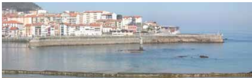
III. IV-2. Vue depuis la route menant à Karraspio : sur le port de pêche et le centre historique de Lekeitio à gauche, sur le large à droite. Au premier plan, la digue du moulin à marée.
