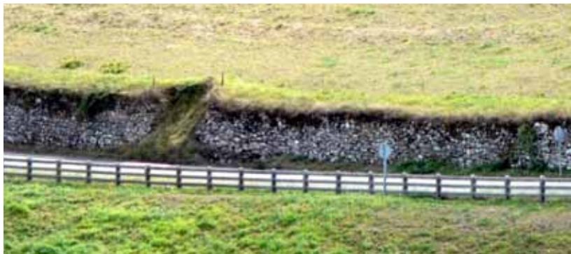
III. 25. Talus engazonné et déblai soutenu par un mur de pierre traditionnel : un beau résultat.
