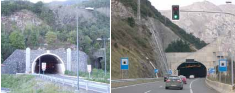
III. 43 et 44. A gauche : île de La Palma (Espagne) : l'entrée du tunnel est constituée d'un mur de pierre (photo : J. T. Rodríguez). A droite : traitement soigné pour cette tête de tunnel sur l'autoroute du Cantabrique (Espagne). Dans les deux cas, le dénivelé surplombant le tunnel a été partiellement pris en compte dans le dessin du parement.
