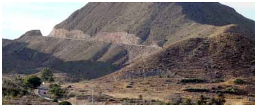
III. 77. Les routes à flanc de coteau produisent un effet de « balafre » dans le paysage qui peut être – partiellement – réduit, lorsque le dénivelé s'y prête, par des mesures de revégétalisation et de traitement des roches.
