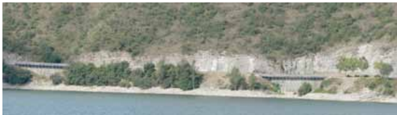
III. III-9. Front de taille et remblai. Ce dernier alterne avec des ponts dont le rôle est double : enjamber de petits ravins et assurer la continuité du milieu naturel entre la pente de la montagne et les rives du lac.
