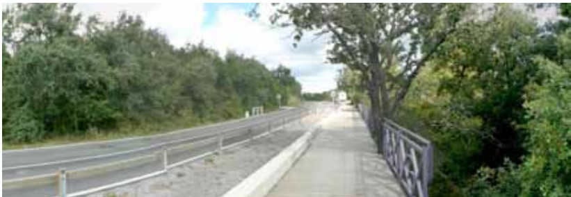
III. 50. Piste cyclable longeant la route. Piétons et cyclistes sont séparés de la circulation par un mur bas et une glissière de sécurité.
