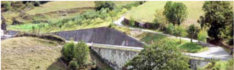
III. 24. En partie dissimulé par un arbre (au premier plan), un mur en éléments préfabriqués soutient le remblai. En face, un mur incliné en béton soutient à la fois les parois du déblai et le dénivelé de la route.
