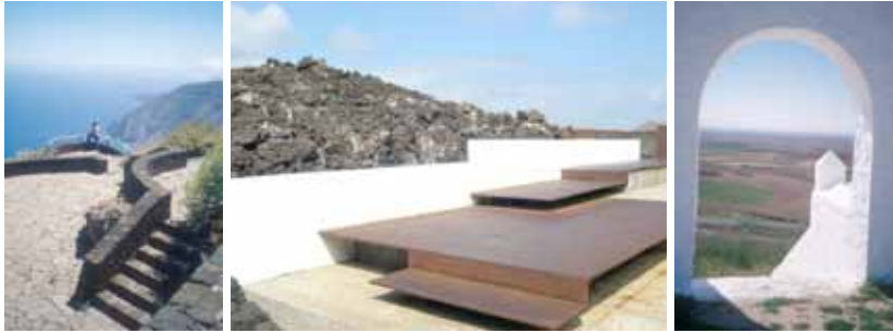
III. 56, 57 et 58. Aménagement des belvédères. A gauche : escalier, chemin et murets de pierre ponctuent le dénivelé menant à la plate-forme d'observation. Au centre : marches en acier oxydé, muret blanc et scories volcaniques. A droite : mur de terre, arche et escalier encadrent la vue.
