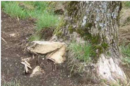
III. 27. Exemple de dommage occasionné par des travaux de dérasement.
