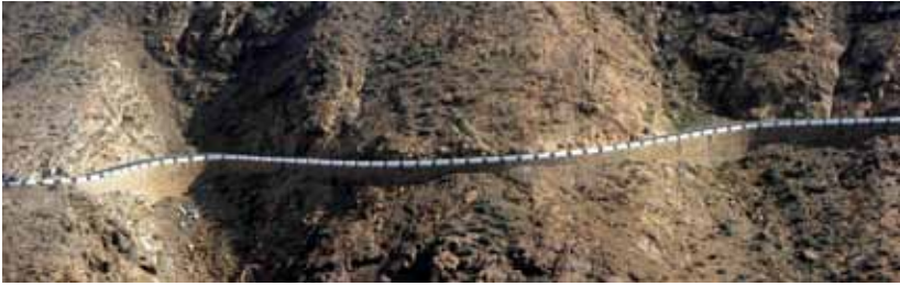
III. 80. Les éléments traditionnels, tels que parapets en créneaux ou murs de soutènement en pierre locale, encouragent une bonne insertion dans le paysage.
