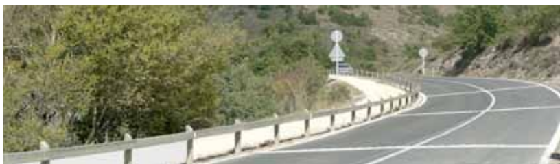
III. III-11. Bandes rugueuses et glissière de sécurité assurent la sécurité et la tranquillité des promeneurs.
