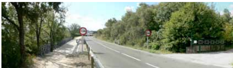
III. III-10. La plate-forme latérale (à gauche) a été construite sans nuire à la végétation, encourageant une continuité écologique d'un côté de la route à l'autre.
