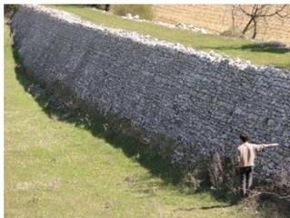
Fig. 97. La restanque (barrage en travers du talweg). Le murailleur montre le résultat du travail réalisé, Suisse.
