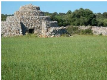
Fig. 72. Construction de pierre sèche pour s'abriter du vent (*Barraca*), Minorque, Espagne.
