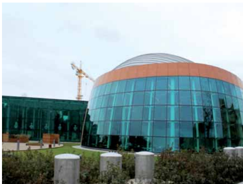
Le centre international de Mugam sur le boulevard de Bakou
