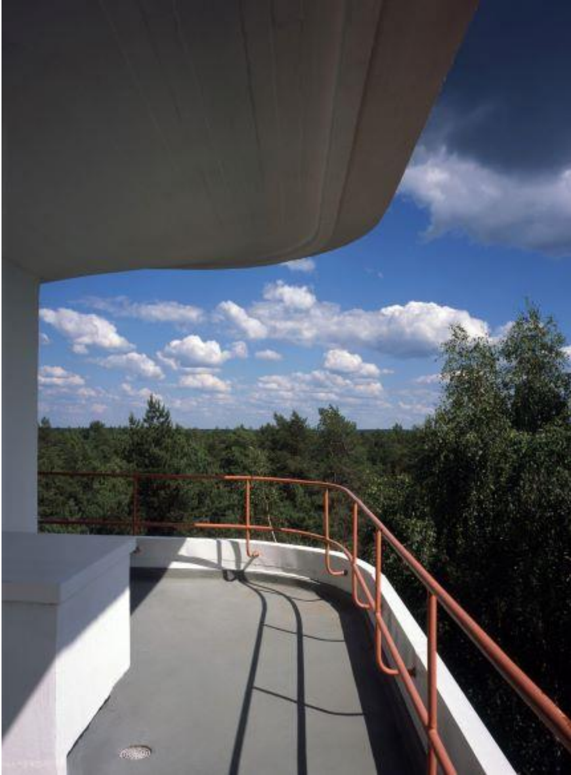
Toit-terrasse du sanatorium de Paimio (1929-33). Photo Maija Holma © Fondation Alvar Aalto
