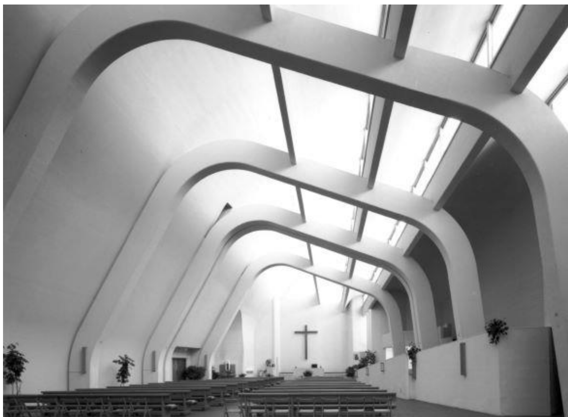
Église et centre paroissial Santa Maria Assunta (1966-80), Riola di Vergato, Italie. Photo Maija Holma © Fondation Alvar Aalto.
