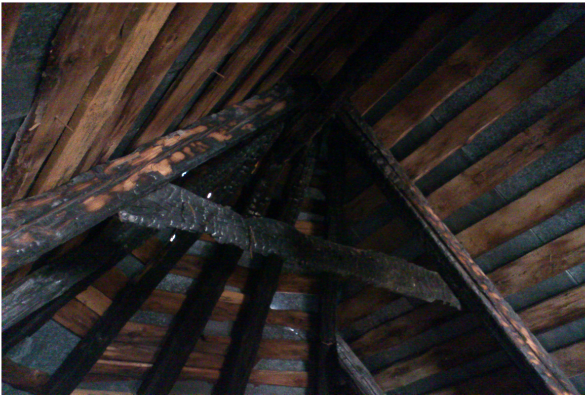
Пошкоджені пожежею конструкції покрівлі
