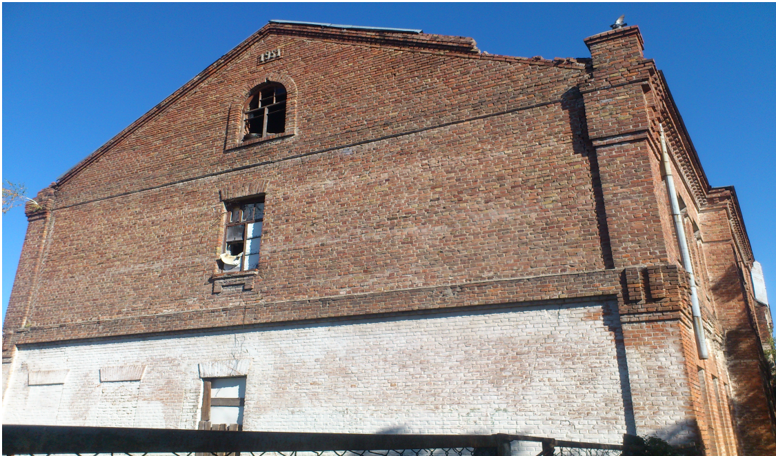
Вид на дворовий фасад будівлі (прибудова 50-х років)
