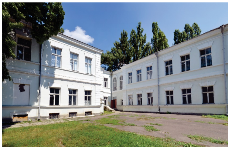
Imagine din curtea edificiului „Domnița Ruxandra” (zona A)
