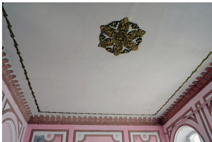
Decorațiuni de pereți și plafon din edificiul „Domnița Ruxandra” (zona A)
