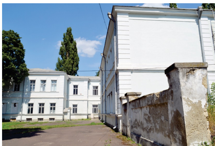
Imagine din curtea edificiului „Domnița Ruxandra” (zona A)
