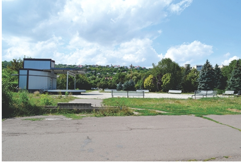
Scuarul Palatului de Cultură cu Teatrul de Vară recent instalat este un spațiu neîngrijit și mai degrabă neatractiv pentru activități în aer liber.
