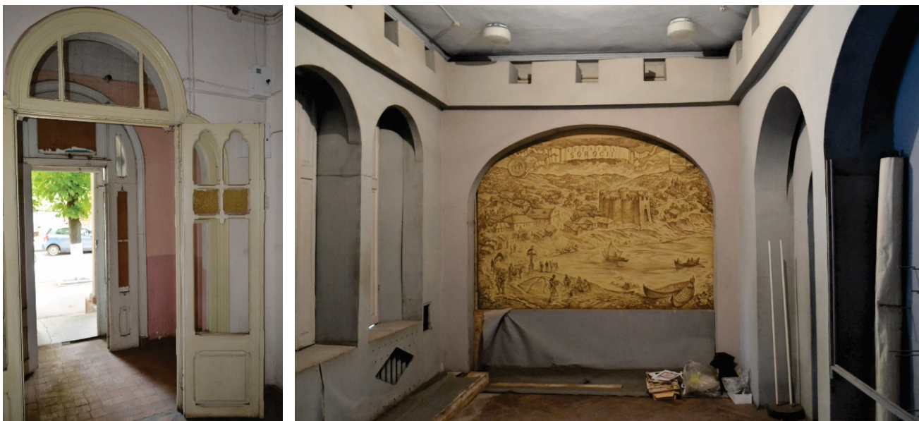
Interiorul clădirii – modificarea pereților cu plăci de gipsocarton
