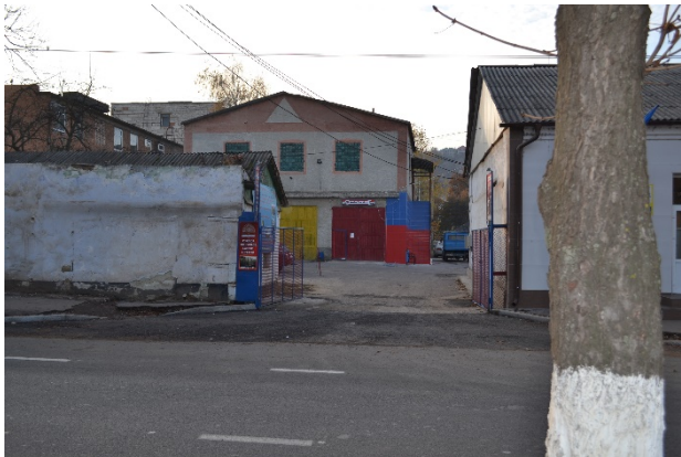
Zonă industrială – depozitare pe strada Independenței
