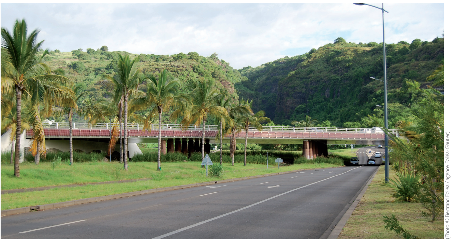
Une continuité paysagère aménagée vers le site naturel des gorges de Bernica, grâce à une ouverture de 62 m. de large sous la Route des Tamarins.
