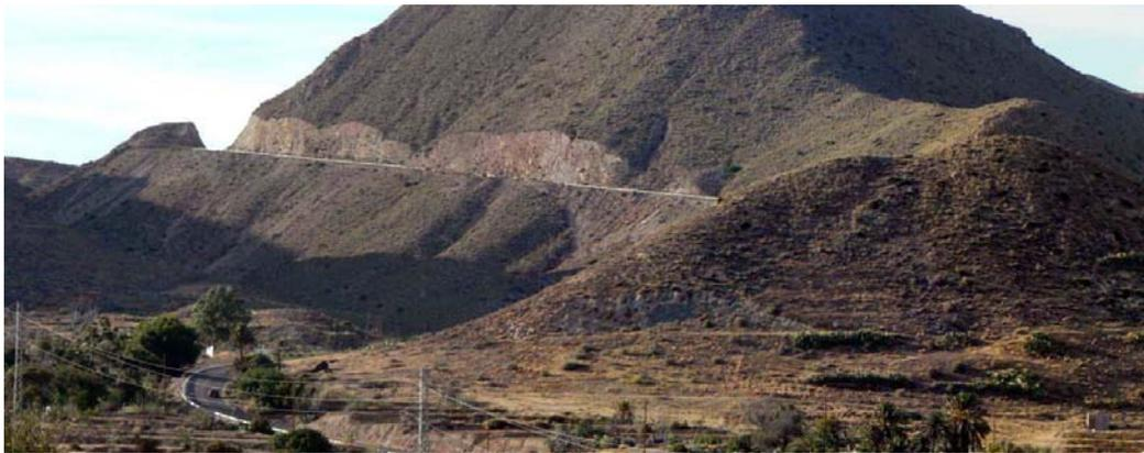
*Fig. 77. Les routes à flanc de coteau produisent un effet de « balafre » dans le paysage qui peut être – partiellement – réduit, lorsque le dénivelé s'y prête, par des mesures de revégétalisation et de traitement des roches.*
