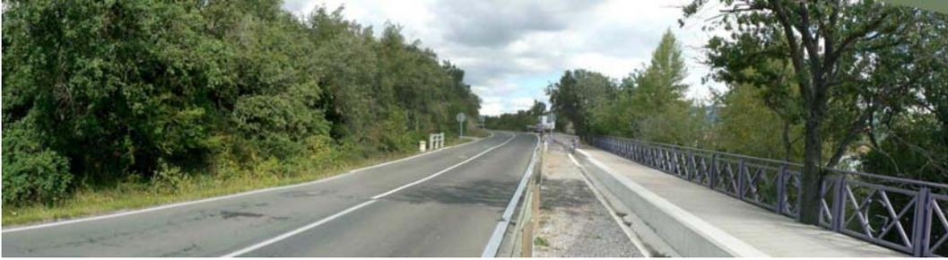
**Fig. III-8.** La construction d'une plate-forme latérale a permis d'aménager un chemin le long de la route. Un muret peint en blanc et une glissière de sécurité séparent les promeneurs de la circulation et une balustrade empêche d'accéder au rivage.
