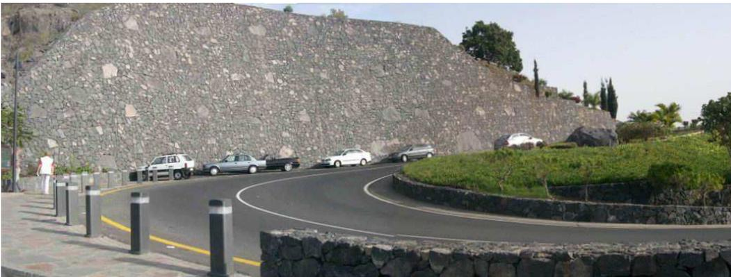
**Fig. 63.** Le mur traditionnel au premier plan est associé à des éléments modernes, comme les bornes de sécurité. Le mur de soutènement est revêtu d'un parement traditionnel en schiste noir, tandis que l'accotement s'agrément de roches et de plantations incluant des essences locales. Ensemble, ces éléments créent une route au caractère bien marqué.
