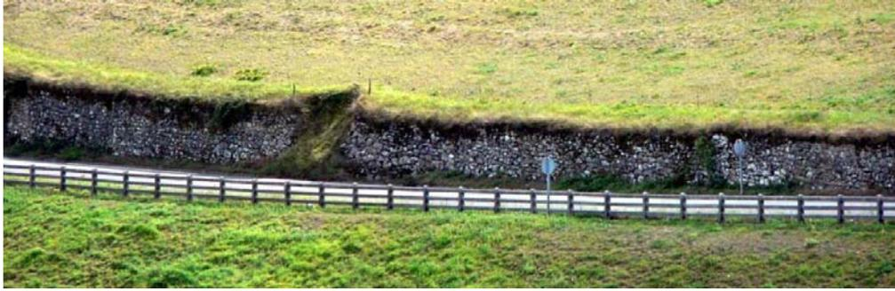
*Fig. 25. Talus engazonné et déblai soutenu par un mur de pierres traditionnel : un beau résultat.*
