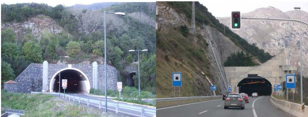
**Fig. 43 et 44. Têtes de tunnels II.** (à gauche) Île de La Palma (Espagne) : l'entrée du tunnel est constituée d'un mur de pierre (photo de J.T. Rodríguez). (à droite) Traitement soigné pour cette tête de tunnel sur l'autoroute du Cantabrico (Espagne). Dans les deux cas, le dénivelé surplombant le tunnel a été partiellement pris en compte dans le dessin du parement.
