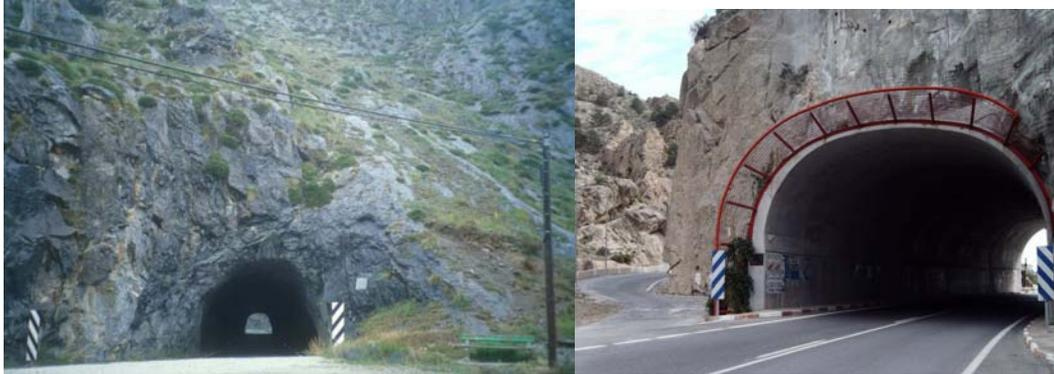
**Fig. 41 et 42. Têtes de tunnels.** (à gauche) Tunnel taillé à même le roc sur une route à une voie, île de El Hierro (Espagne). (à droite) Un tunnel dans le val de Ricote, région de Murcia (Espagne) : auvent de protection décoratif et roche revêtue d'un enduite (photo : L. Cruz).
