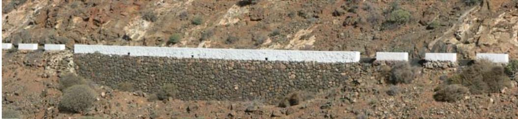
*Fig. 26. La plate-forme de la route repose sur un mur revêtu d'un parement en pierres locales. Associée à un pittoresque parapet de couleur claire, cette solution s'avère aussi esthétique que fonctionnelle.*
