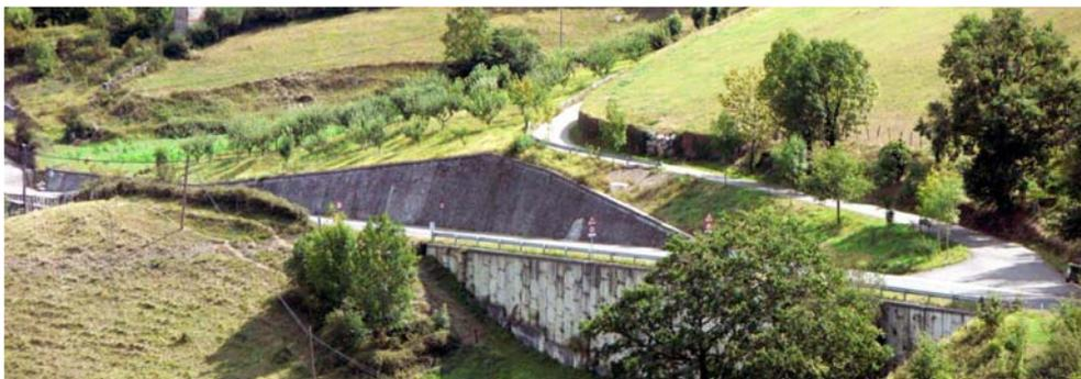
**Fig. 24.** En partie dissimulé par un arbre (à droite de la photo), un mur en éléments préfabriqués soutient le remblai. **En face**, un mur incliné en béton soutient à la fois les parois du déblai et le dénivelé de la route.
