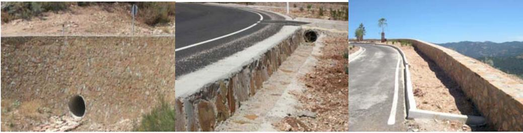
**Fig. 60, 61 et 62.** Lorsqu'il est utilisé pour plusieurs éléments de voirie (murs de soutènement, fossés d'écoulement, parapets), le grès contribue à créer un sentiment d'identité et de cohérence.
