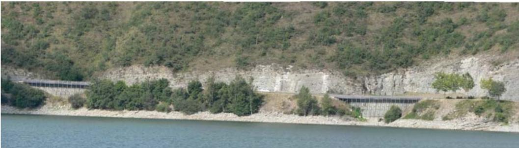
**Fig. III-9.** Front de taille et remblai. Ce dernier alterne avec des ponts dont le rôle est double : enjamber de petits ravins et assurer la continuité du milieu naturel entre la pente de la montagne et les rives du lac.
